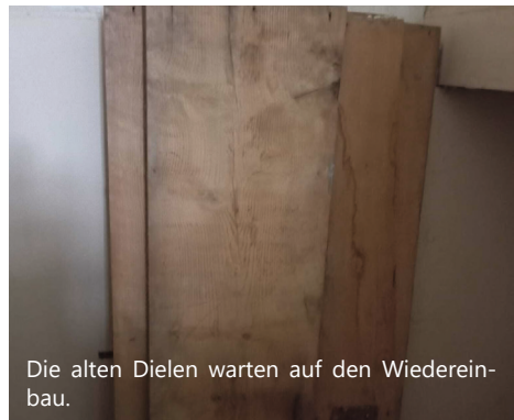
Die alten Dielenbretter müssen noch verlegt werden.
