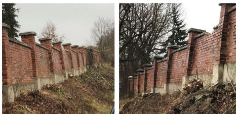
Die ansässige Firma Drewlo/Feustel GmbH übernahm die Arbeiten und im April 2018 begann der erste Bauabschnitt an der Westseite: Abriss der alten Abdeckung, teilweise Abtragen der Ziegelschichten, Abschnitte mit Komplettabriss, Ziegel abklopfen zur Wiederverwendung, ausbaggern, neue Fundamente machen, Abraum beseitigen,
